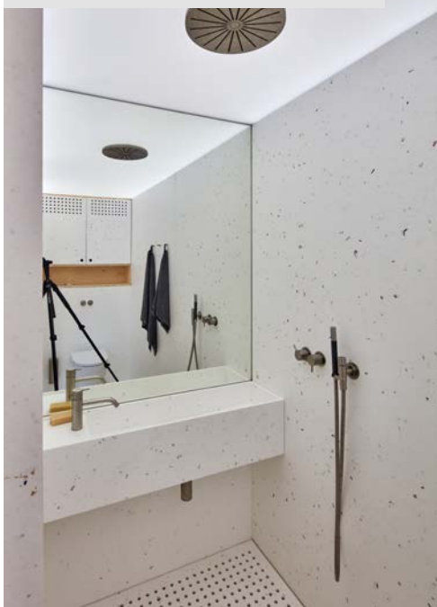
Obklad koupelny z desek z recyklovaných jogurtových kelímků (tým coLLab)
