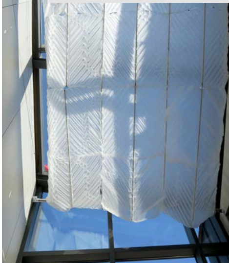
Zastiňovací prvek v proskleném vstupním prostoru s výplní sojovým voskem se změnou skupenství, kdy se podle teploty mění z neprůsvitného na čirý (tým 1 House for all)
