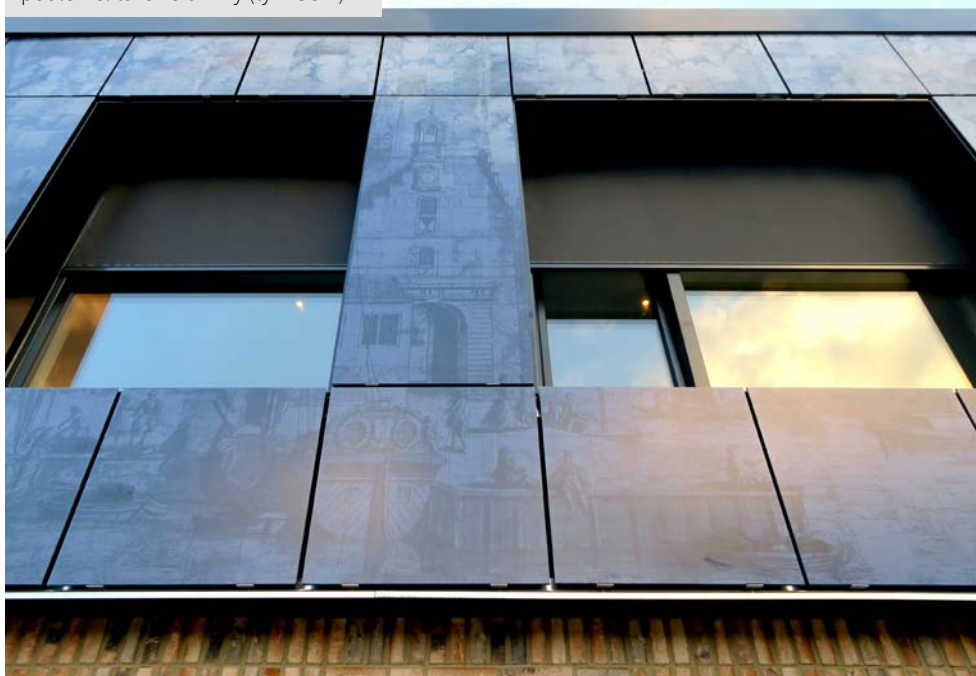
Fotovoltaický obklad stěn s potiskem podle Delftské keramiky (tým SUM)
